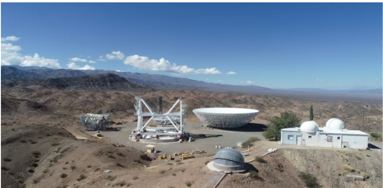
Figura 1. Etapa de ensamble final del CART (nov. 2025)
