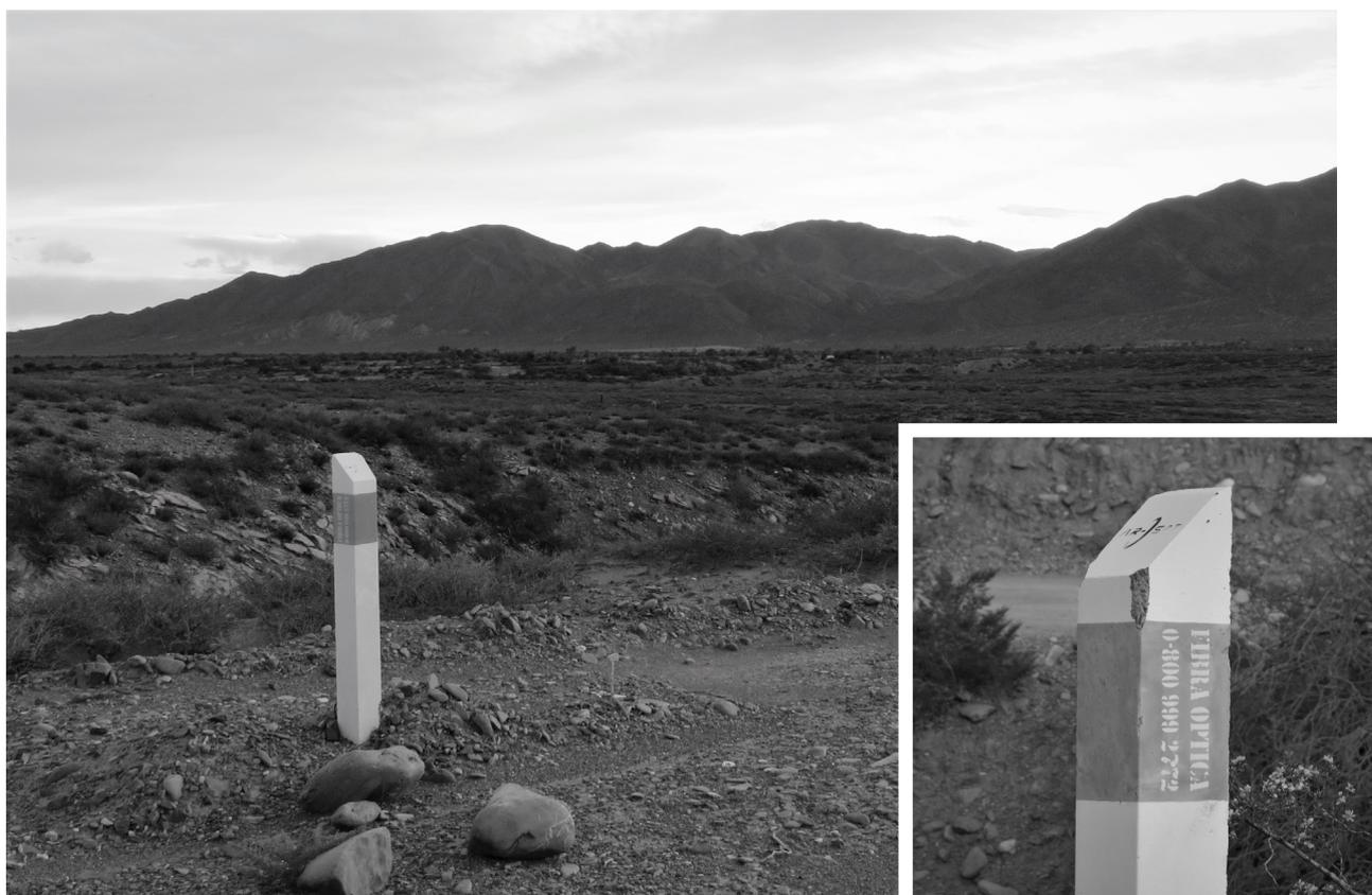
*Hitos de hormigón utilizados para la identificación del enlace de fibra óptica y las cámaras de paso y de empalme. Colocados cada 1 Km. La foto fue tomada en el km 4551 de la ruta 40 (Provincia de Salta)*
