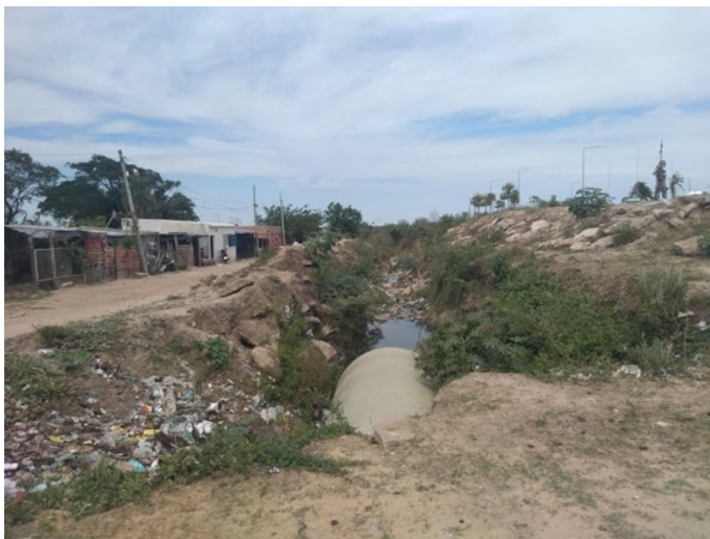
Figura 9: Asentamiento Bajo Caridi junto a canal aliviador del entubado del Arroyo Limita que finaliza en zanja contaminada.
