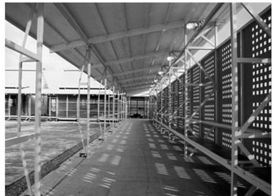
Figura 17. Centros Culturales Comunitarios realizados en Venezuela, Adolfo Peña, con tecnología prefabricada, teniendo en cuenta las condiciones del trópico y brindando espacio para la interacción social.
