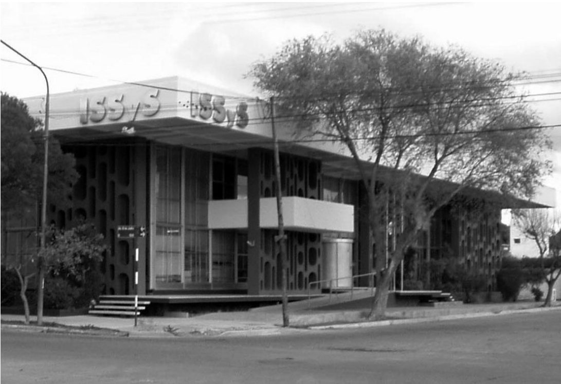
Figura 5. Instituto de Seguridad Social y Seguros de la provincia del Chubut.
