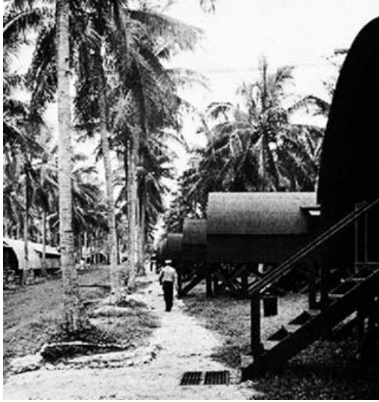
Figura 4. Hospital Naval Nº3, Santo Espiritu. Nueva Zelanda. Fuente: < http://www.ibiblio.org/hyperwar/USN/Building_Bases/img/bases2-p209.jpg >
