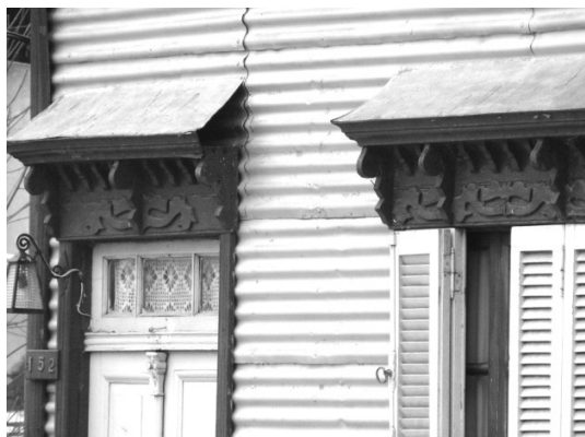
Figura 8: Ornamentos de fachada
