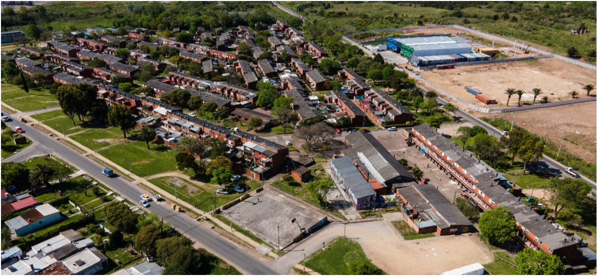
Figura 7. Cooperativa Nuevo Amanecer. Perspectiva del conjunto a vuelo de dron, vista desde el suroeste.
