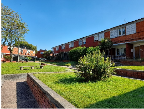
Figura 14. Cooperativa Nueva Amanecer. Vista de las sendas peatonales.
