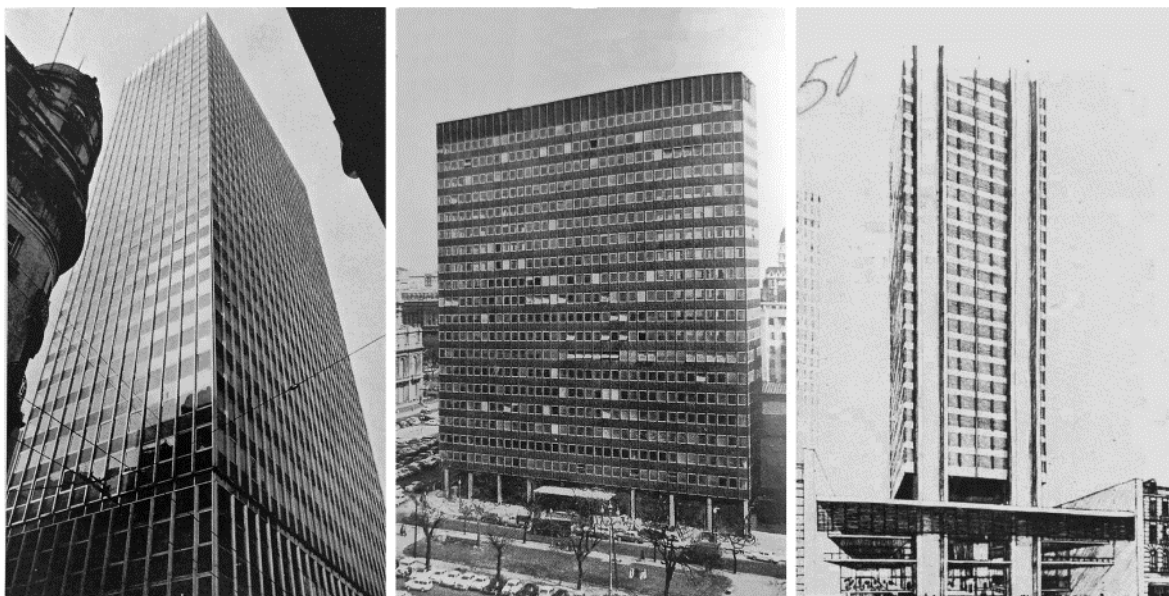
Figura 6: a. Edificio Brunetta - b. Torre FIAT- c. Edificio del Jockey Club.
