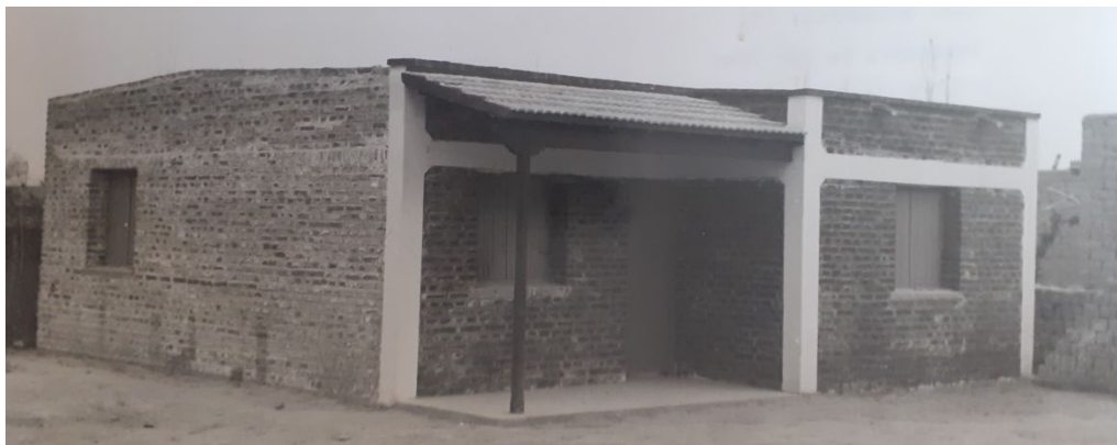
Figura 13: Casita del Ministerio de Reconstrucción.
