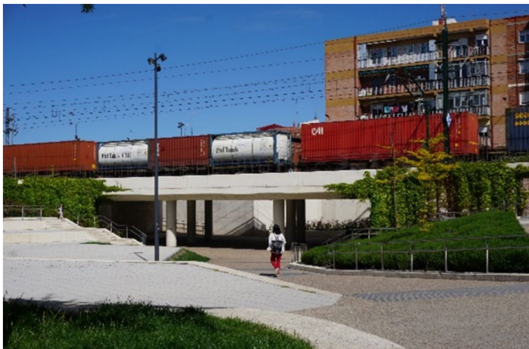
Figura 3: paso inferior peatonal de Pilarica (el ferrocarril discurre a nivel).
