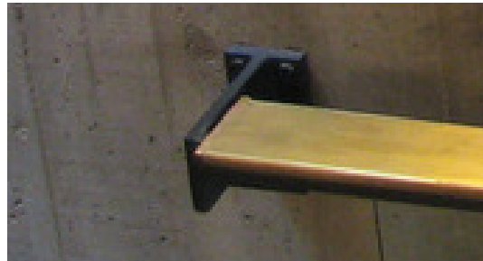
Figura 8. Detalle de los amarres de las barandas de las escaleras
