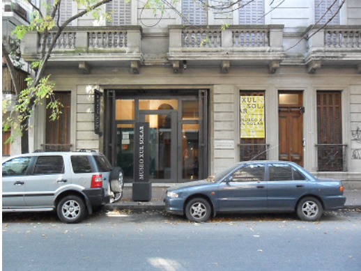
Figura 1: Fachada actual del Museo Xul Solar
