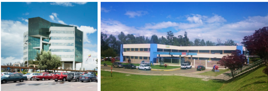
Figura 20 y 21: Edificio de oficinas del rectorado y edificio de oficinas y laboratorios de ingeniería mecánica. ESPE
