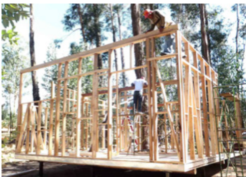
Figura 8 y 9: Estructura del edificio
