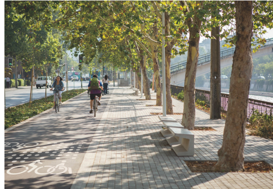
Fig.10 Cicloparque Mapocho 42K ejecutado en Tramo Central de Providencia_2016
