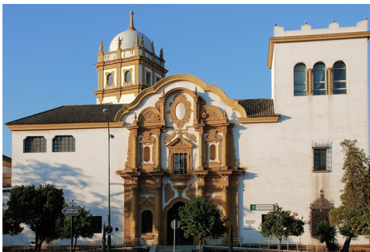
FIGURA 6 Pabellón de la Argentina. Arquitecto Martín Noel. Fuente: elaboración propia
