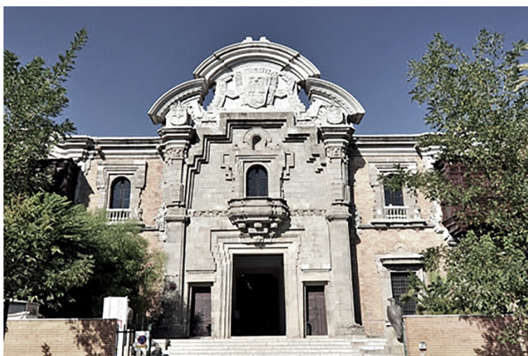
FIGURA 4 Pabellón del Perú. Arquitecto Manuel Piqueras Cotoí.
