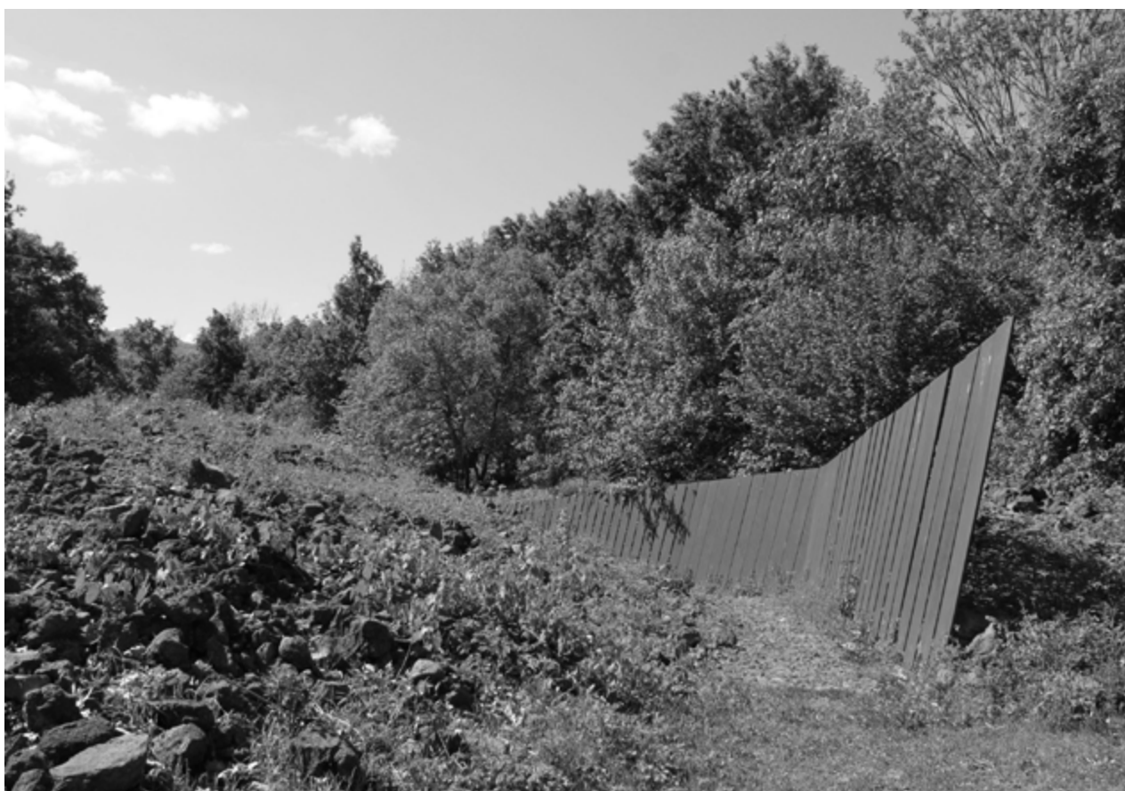
Figura 7. Acceso al Parc de la Pedra Tosca como nuevos bancales de acero corten
