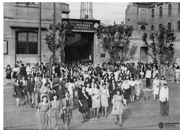
Figura 2. Salida de las obreras de la fábrica de fósforos. Fuente: Archivo General de la Nación
