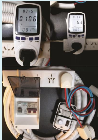
Figura 18. Arriba a la izquierda, motor sincrónico tipo PMSM/IPM testeado con circuito de eficiencia energética (EE) encendido. Potencia activa 6,3 (watts) en todo circuito R-C-L. Arriba la derecha, factor de potencia (f.d.p.) equivalente a 0.81 (coseno \Phi ). Abajo, detalle de las conexiones eléctricas de la llave térmica y el disyuntor diferencial del banco de pruebas y la reactancia inductiva conectada en serie a una fase, en su interior junto al capacitor en paralelo a las dos (2) fases en el punto de acople (aguas abajo). El capacitor en paralelo conectado a las dos fases, va unido a la reactancia-inductiva en serie a una de las fases, que es el secreto del funcionamiento del motor sincrónico PMSM/IPM de bajo consumo energético y alta Eficiencia Energética(EE); su secreto se guarda para la reivindicación acorde a la Ley de Patentes N° 24481 modificada por su similar N° 24.572 (T.O. 1996) y su Reglamentación (no se muestra para preservar la novedad y no divulgación previa).
