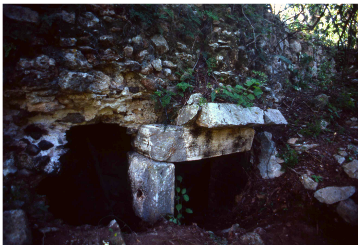
Figura 3: Vano de entrada del Cuarto 2 del Edificio de las Pinturas de Ichmac, Campeche. Fotografía tomada en mayo de 1998 por el autor.
