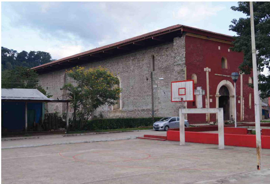
Figura 4. Fotografía de la nave del Exconvento de Santo Domingo de Guzmán, Oxolotán. Toma de noroeste a sureste.
