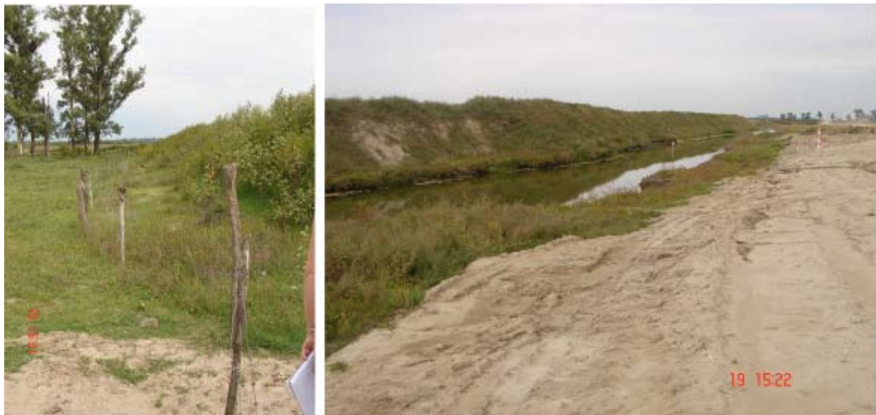
Vista desde el exterior del emprendimiento
