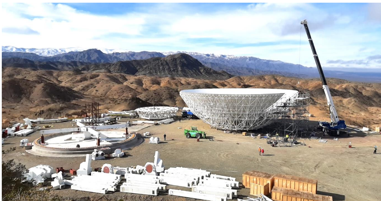
Figura 1. Etapa del armado de CART en la estación cordillerana Cesco del OFA. A la izquierda se observa la estructura subterránea de la base circular donde irá montado el radiotelescopio y a la derecha puede apreciarse sobre el suelo la construcción de la antena, la cual está a punto de completarse con la colocación de los últimos paneles de aluminio (imagen mayo 2024).
