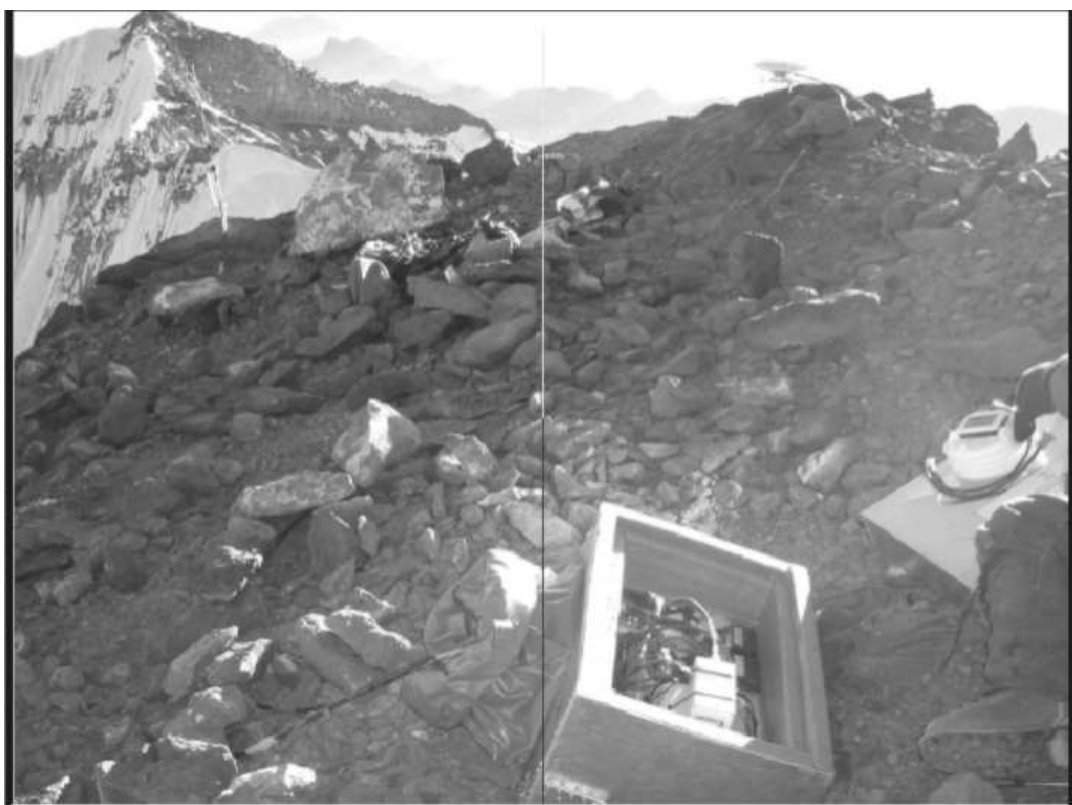
Figura 4 Instalación de GPS en la cumbre del Co Aconcagua
