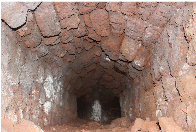
Figura 6. Interior del conducto subterráneo de la estructura
